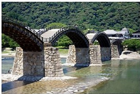
Để giảm lực tác động lên cây cầu người ta thiết kế cầu có dạng hình parabol quay bề lõm xuống phía dưới.
