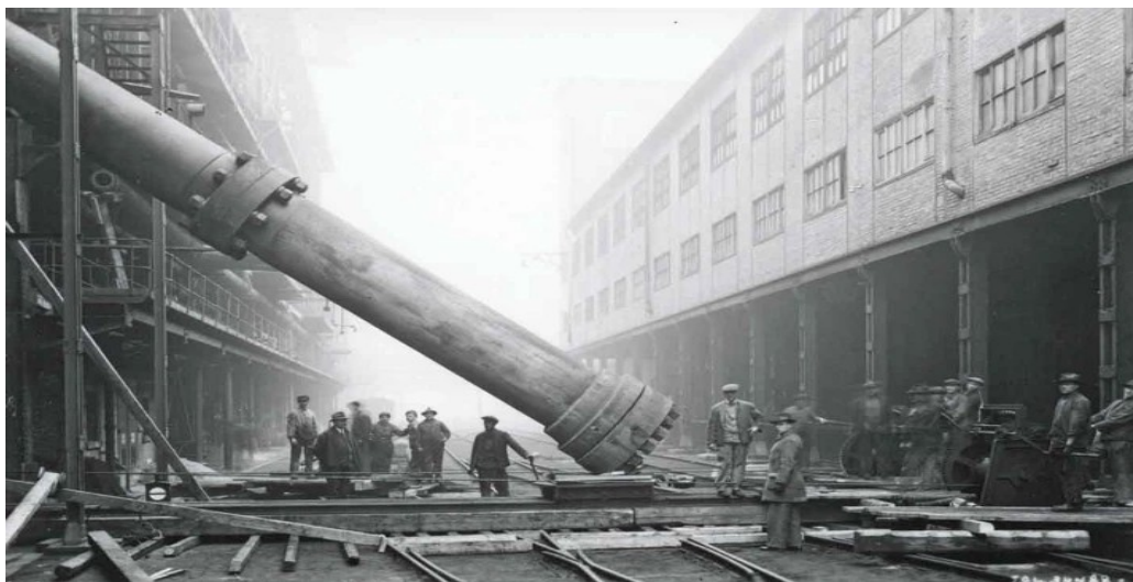
Một nhà máy tại Đức lắp đặt các lò phản ứng tổng hợp ammonia ở áp suất rất lớn và nhiệt độ cao năm 1923. Ảnh:
