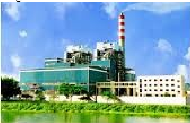
Nhà máy nhiệt điện Long Phú tỉnh Sóc Trăng
