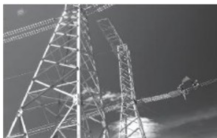
Dây điện cao thế thường dùng vật liệu là nhôm.
