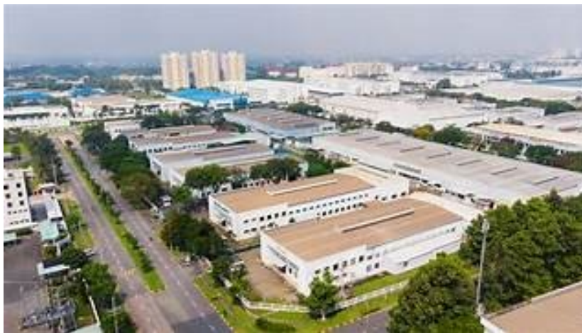
Khu công nghiệp Vsip Hải Phòng
