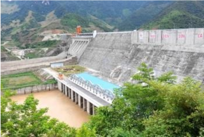
Nhà máy thủy điện Sơn La
